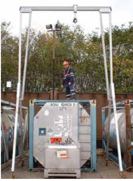
Düşme önleyici ünitesi ile birlikte, 2 kişilik 240 kg kapasiteli uzun portal vinç uygulaması
